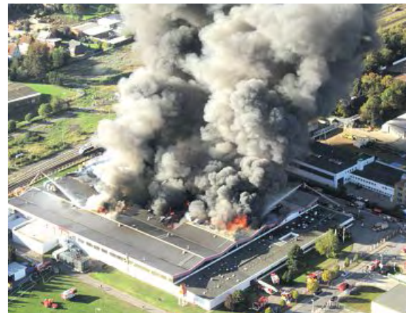
Großbrand bei der Firma Lear in Quakenbrück.
