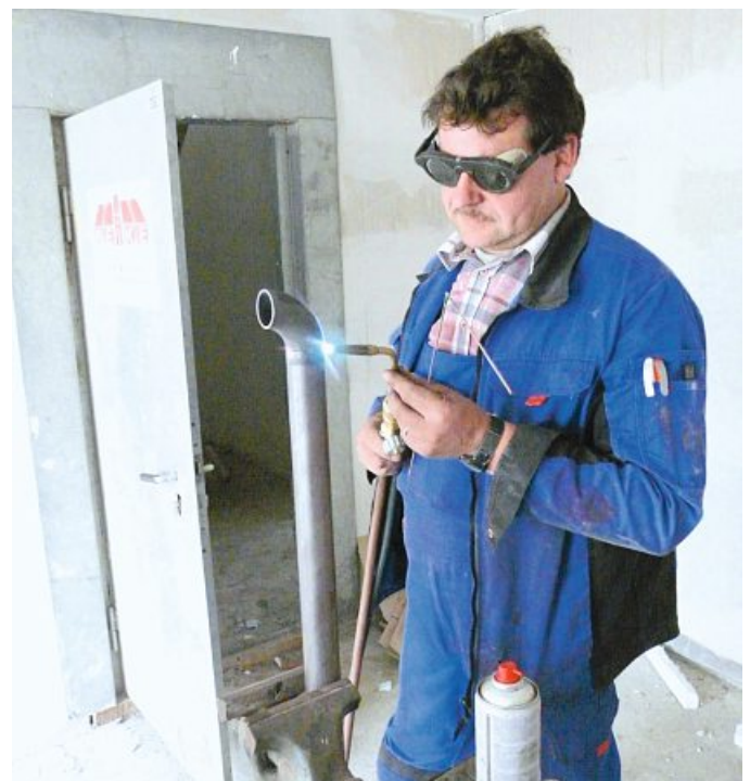
Heizungsmonteur vor Ort: Optimistische Konjunkturaussichten
